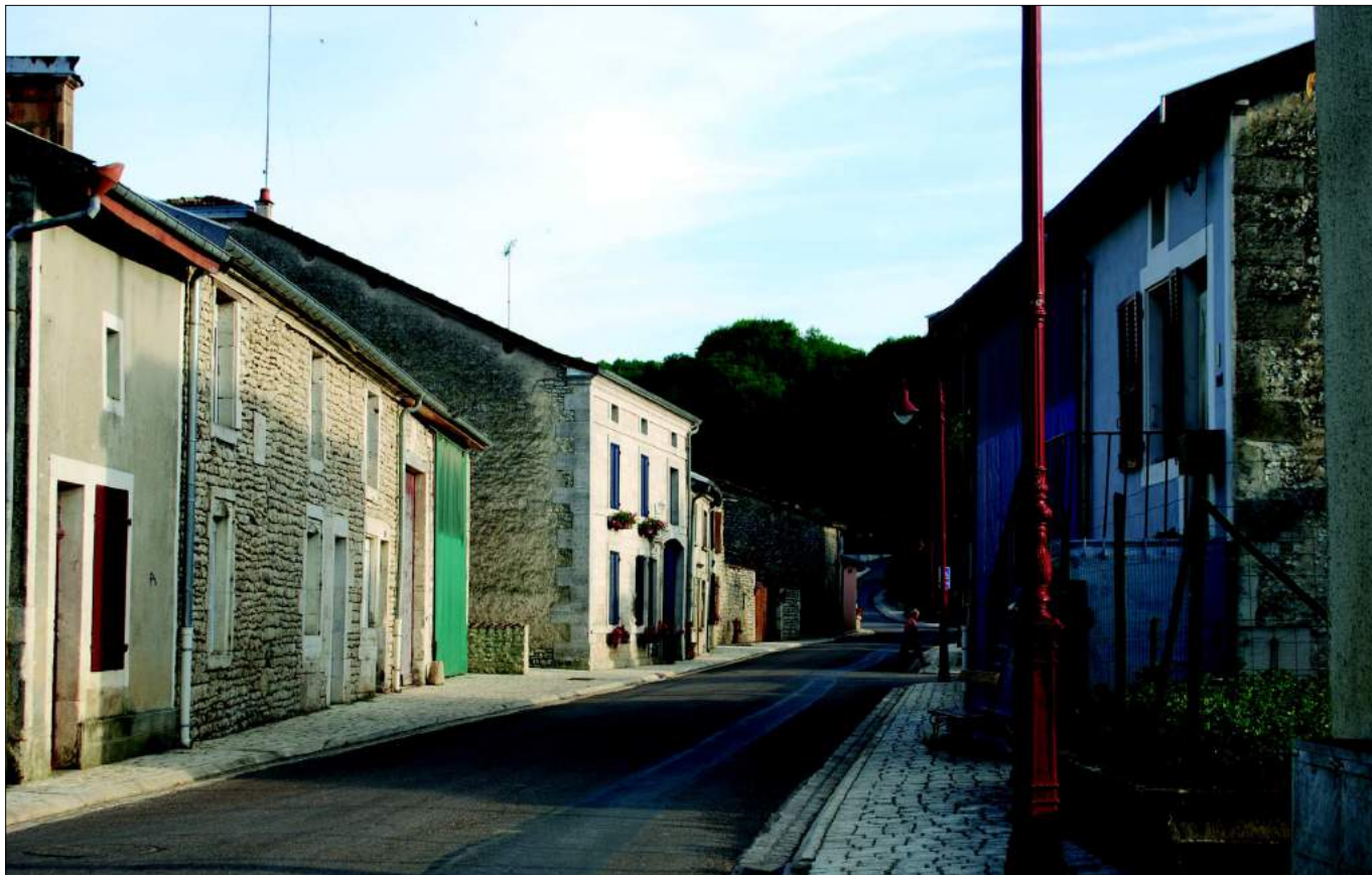
Effincourt et son bâti traditionnel de calcaire blanc
