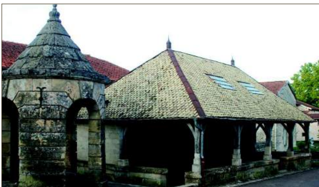
Lavoir et puits à Ambonville
