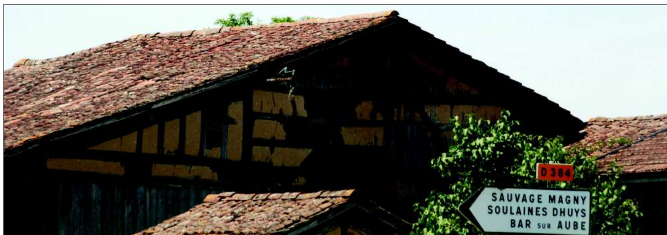
Un bâtiment traditionnel en pans de bois et torchis à la Grève, en ruine
