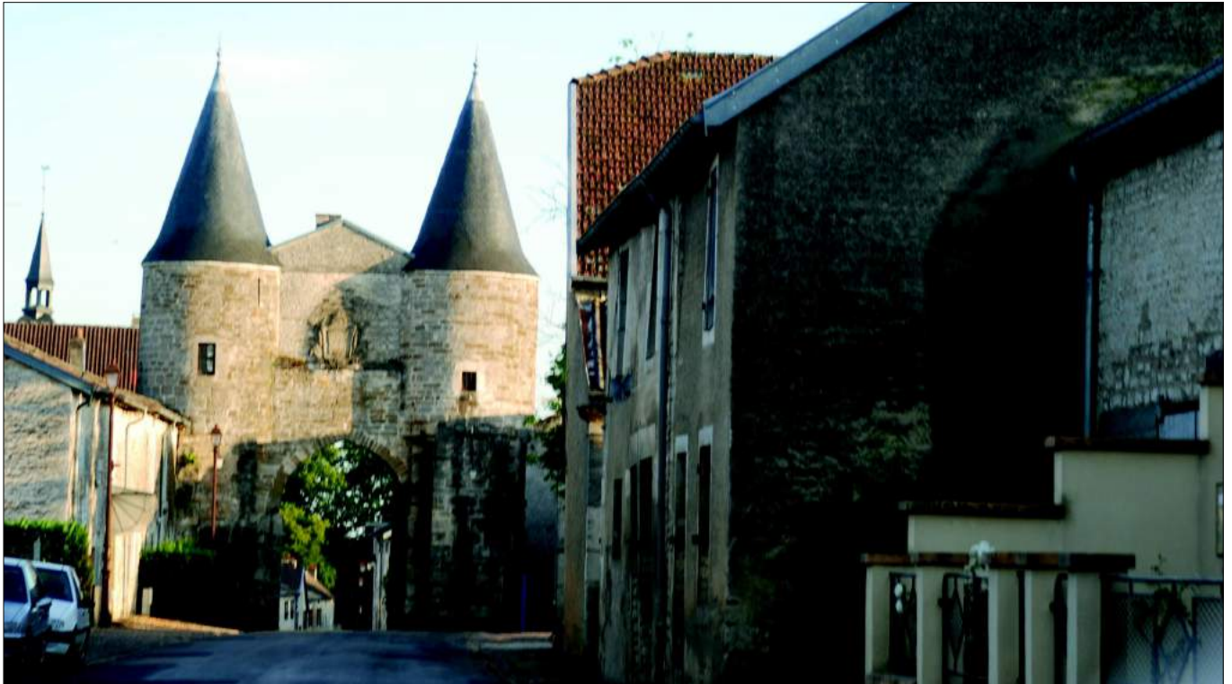
La porte médiévale de Reynel, site bâti perché défensif dominant le vallon des Battants
