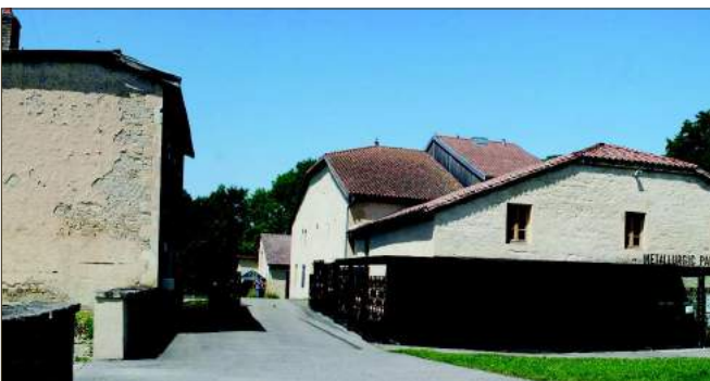
Metallurgic Park, site de haut-fourneau mis en valeur à Dommartin-le-Franc
