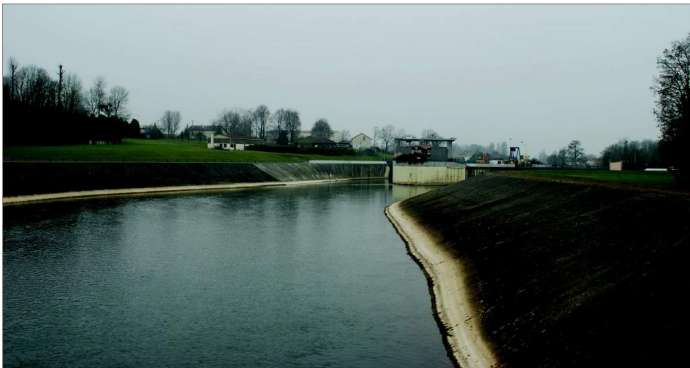
La Marne canalisée à l'approche du canal d'amenée du Lac du Der.
