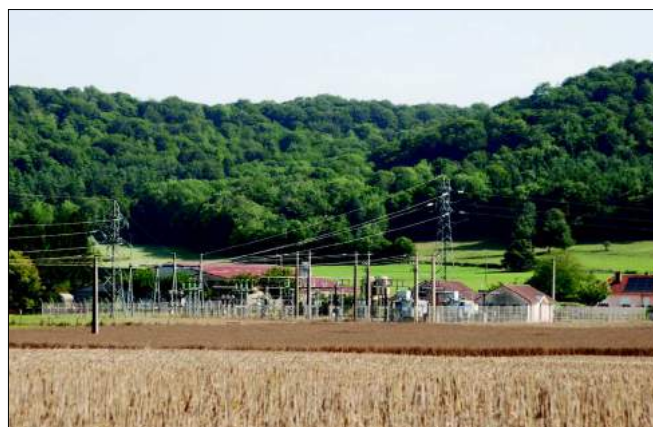
Poste électrique à Vesaignes-sous-Lafauche
