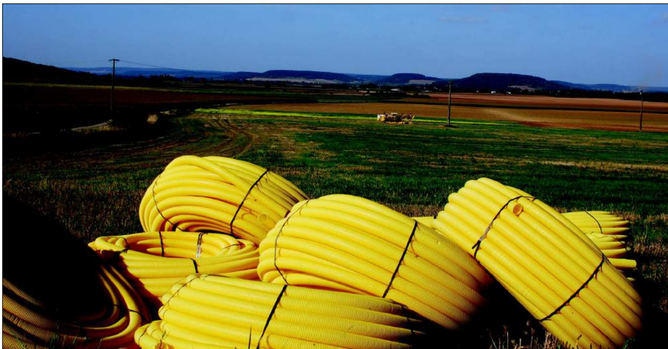
Un drainage en cours, qui conduit à la disparition des prairies et pâtures
