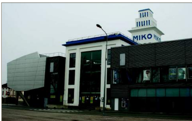
Exemple de réhabilitation réussie du patrimoine industriel de Saint-Dizier, dans le cadre d'une opération de construction contemporaine de qualité.
